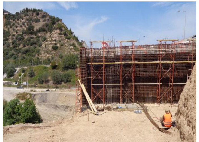
B269 – Κατασκευή αριστερού οπίσθιου τοίχου
