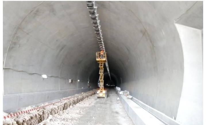
Σήραγγα Πλατάνου/Βόρεια Εκσκαφή – Εγκατάσταση Η/Μ υποδομών
