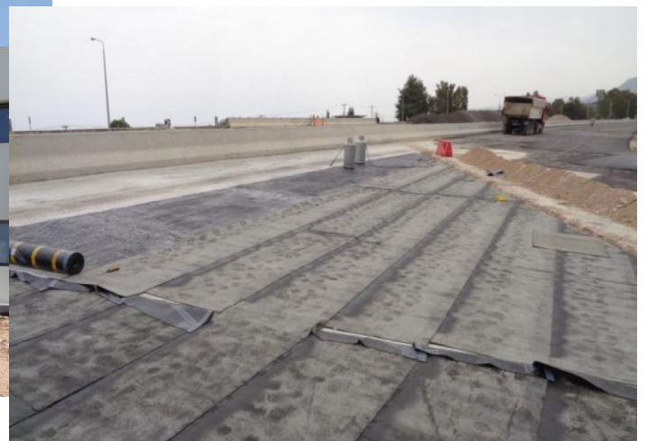
K317 – Εγκατάσταση πλάκας υδατοστεγάνωσης καταστρώματος
