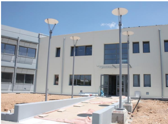
Κυρίως κτίριο ΚΕΣ Νέας Περάμου
