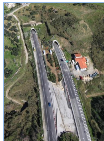
Άποψη της υφιστάμενης κατάστασης της ΕΠΠ
