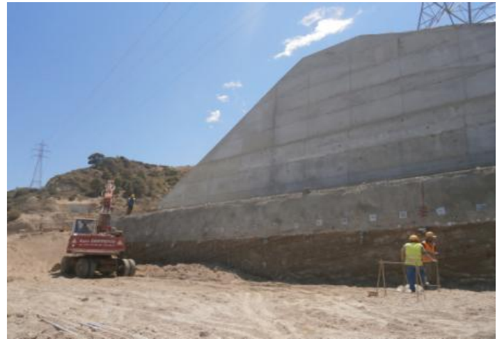
O383 – Κατασκευή περιοχής ορύγματος
